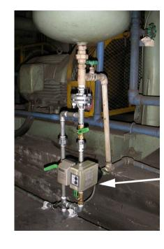
縦型配管に直接 繋ぎ使用 配管を変更 することなく ドレン抜きを実現
