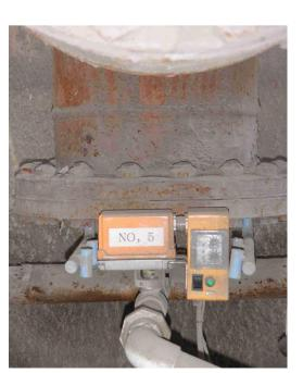
大口径配管 のエルボ部 のドレン抜 きに使用
